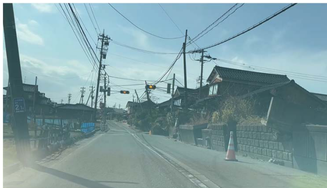
【内灘町】液状化した道路
