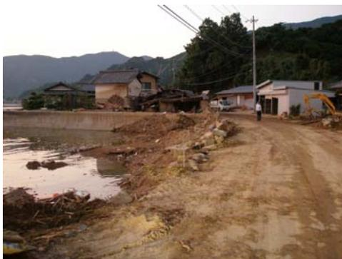
【宇和島市】土砂崩れによる護岸等の流出（白浦地区）
